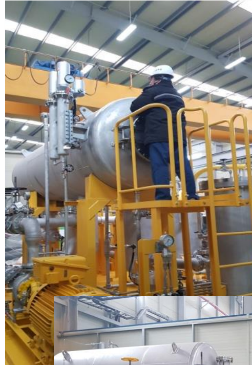
Skid module assembly
