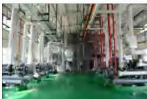
烟台冰轮冷冻机间工程
